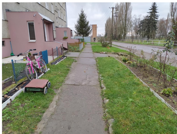
obszar po stronie wschodniej budynku
