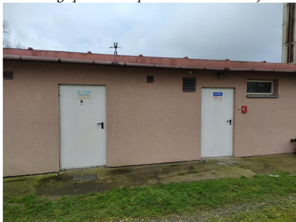
kotłownia osiedlowa po stronie południowej
