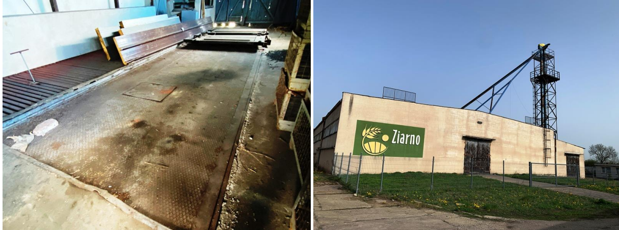
Fot. Widok ogólny stanowiska rozładunku i elewatora.
