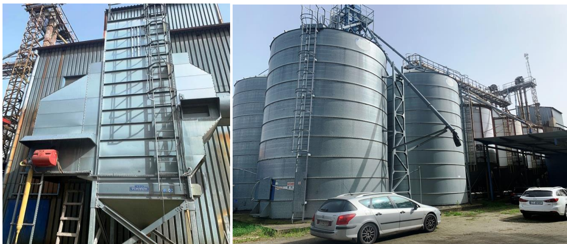
Fot. Widok ogólny suszarni oraz silosów. Źródło: zdjęcia własne.
