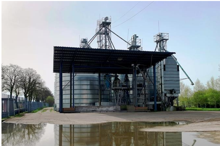
Fot. Widok ogólny instalacji.
