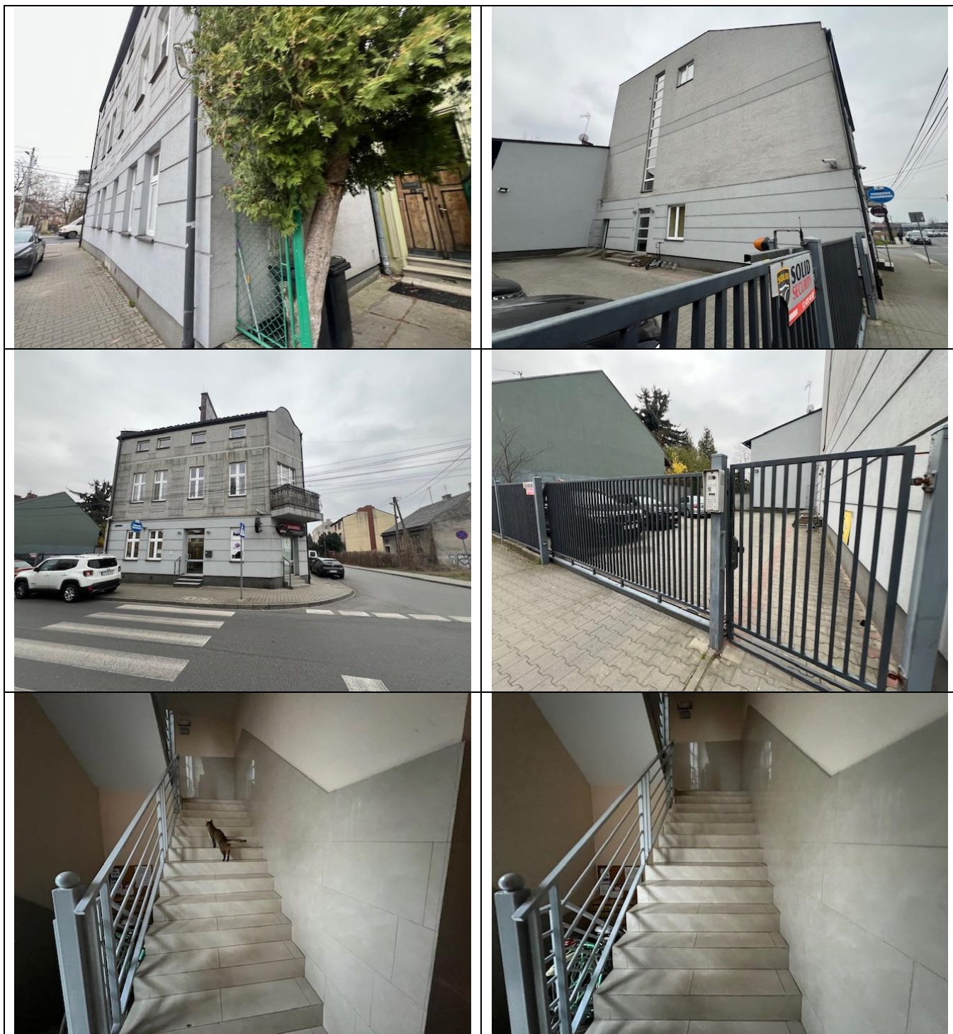
ogólny widok budynku i części wspólnych
